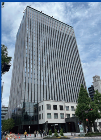
新庁舎は、震災対応にも優れ、大規模災害時にも市民への情報発信、生活再建・復興の中枢拠点として役割を担います。
